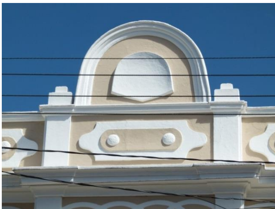
Figura 18. Rebites em fachada de residência em Socorro, SP (detalhe)
