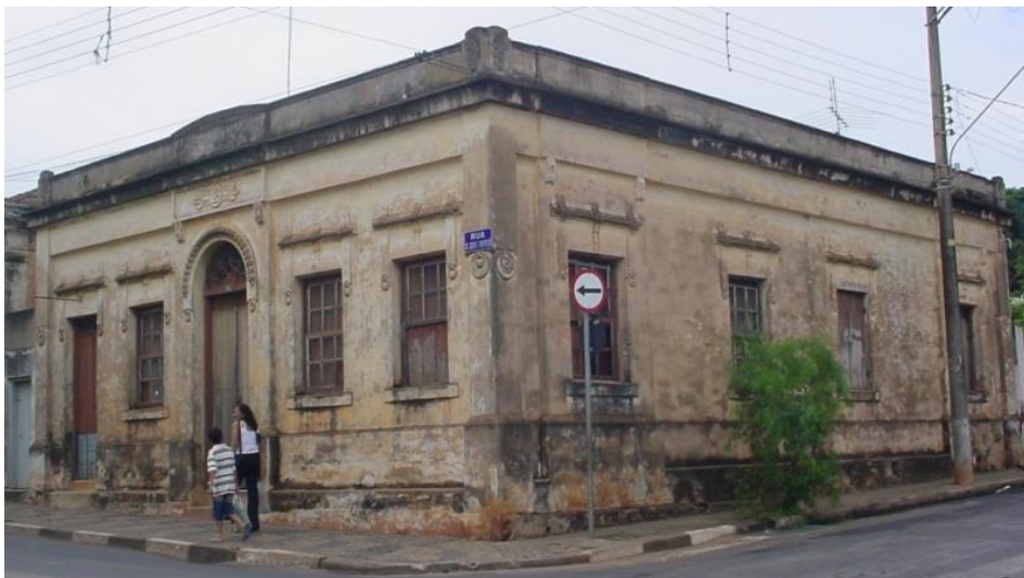
Figura 15. Correntes na residência à Rua Jorge Tibiriçá em Santo Antônio de Posse, SP
