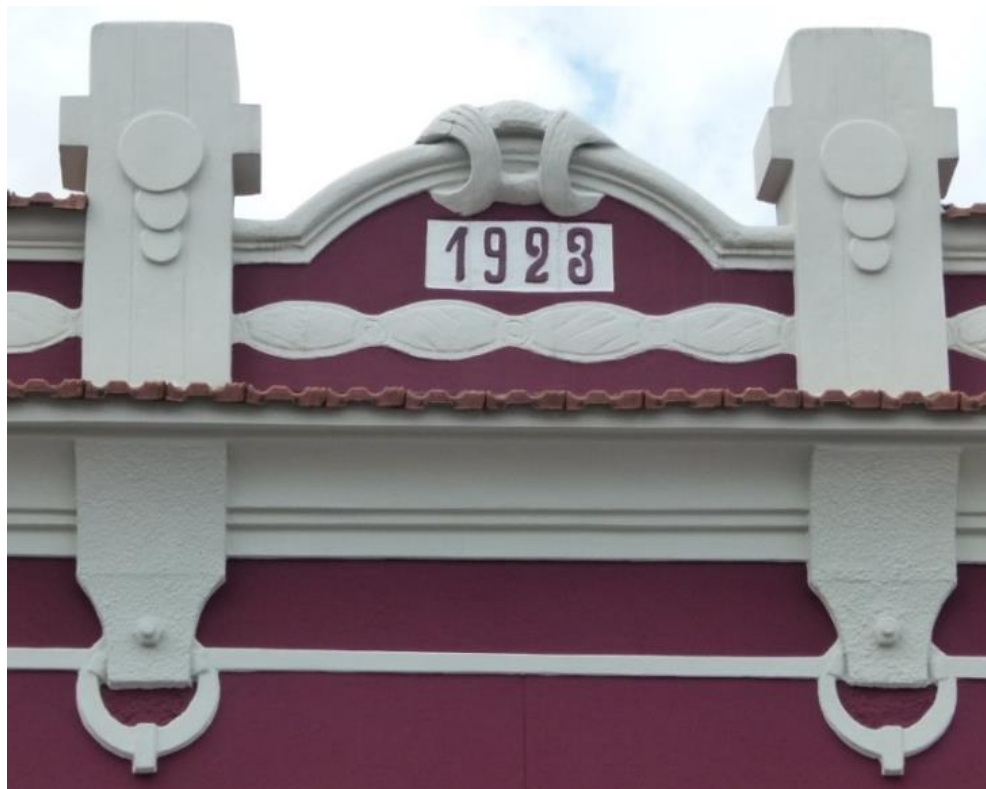
Figura 3. Barras de ferro chato ligam as argolas entre si e impedem o movimento
