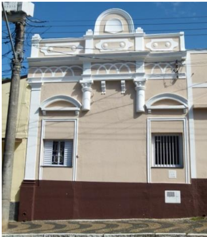
Figura 17. Rebites em fachada de residência em Socorro, SP
